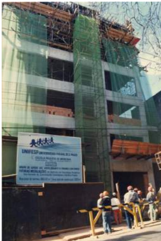
Nesta página e na anterior, construção do prédio do Hospital, projetado por Jacinto Guidolin, que era presidente do GRAACC e engenheiro responsável pela obra, em diversas etapas da construção, 1996.
